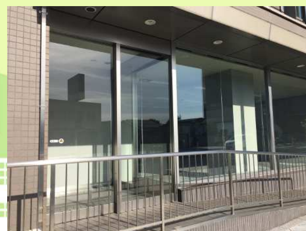
外部に面した専用の出入口(風除室、自動ドアあり)
